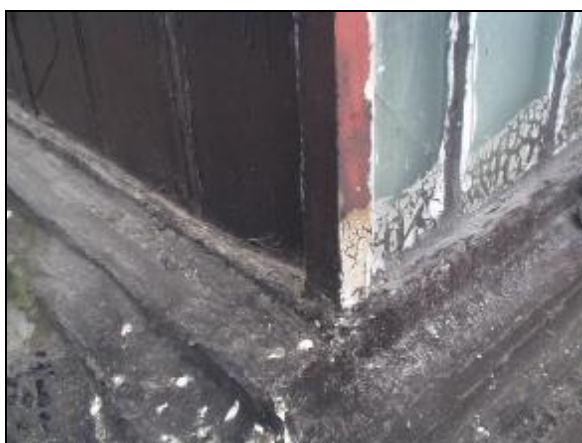
foto /33/ Roh copilitové stěny
