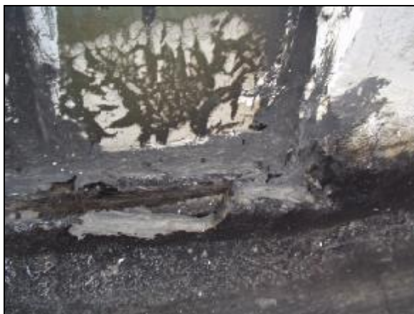
foto /30/ Detail rozšpachtlování hydroizolace
