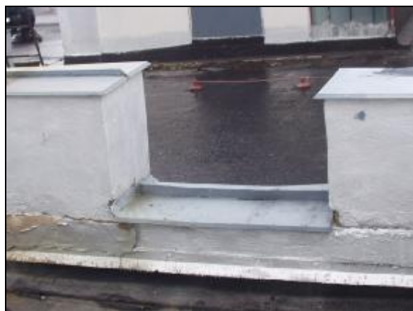
foto /16/ Průchod v dilatační atice
