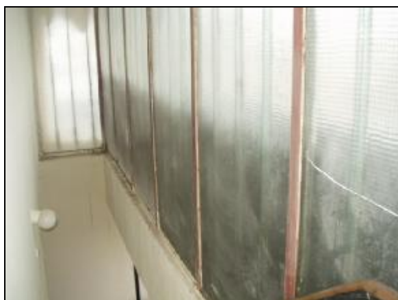
foto /32/ Copilitová stěna z interiéru
