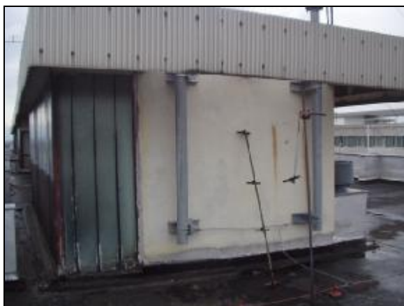
foto /24/ Pohled na strojovnu výtahu
