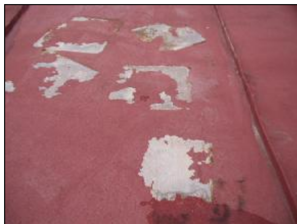
foto /25/ Střecha strojovny
