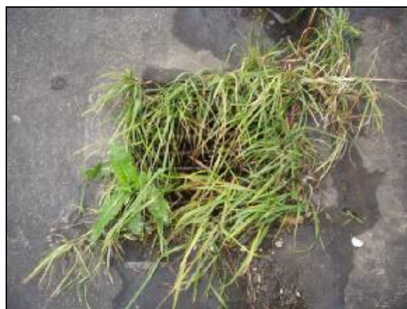
foto /19/ Vegetace u střešního vtoku
