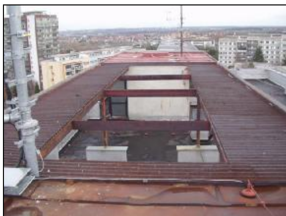
foto /3/ Pohled na zastřešení mezi strojevnami
