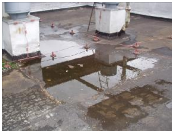
foto /9/ Kaluže vody na vrchní stěře
