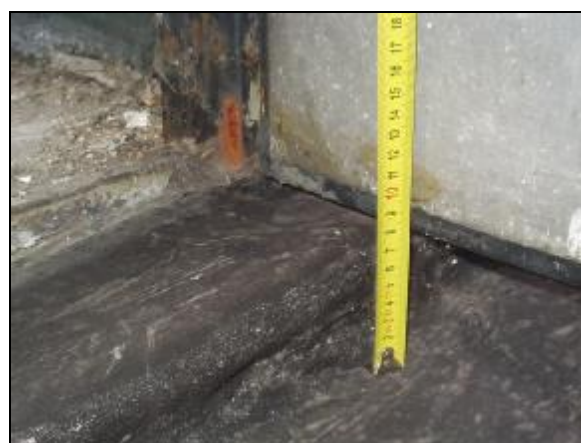
foto /34/ Vstup na střechu
