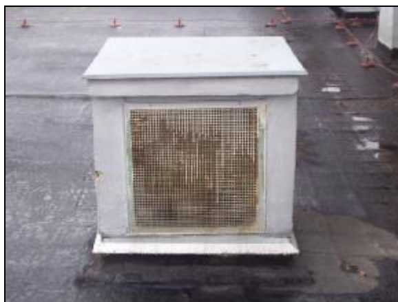
foto /23/ Ventilační šachta
