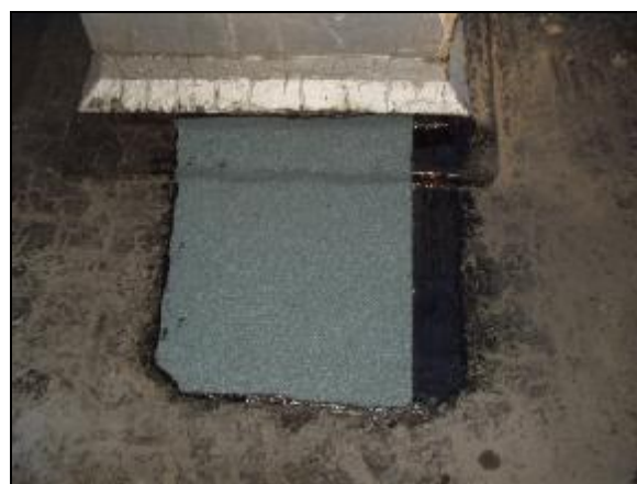
foto /7/ Uzavření sondy S2 přířezem asf. pásu
