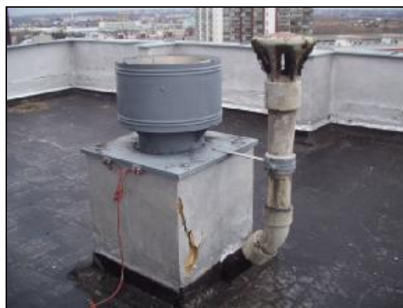
foto /21/ Prostup odvětrávání kanalizace
