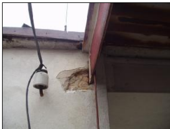
foto /29/ Napojení nosného profilu na stěnu
