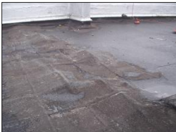
foto /10/ Zvlnění stěrky a teracových dlaždic
