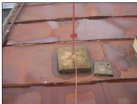
foto /38/ Jímací tyč bleskosvodu
